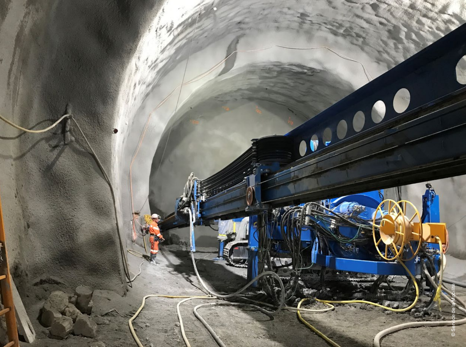
Chantier du Tunnel des Évouettes (Valais).
